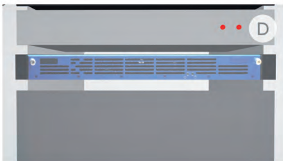
Serveur d'appel malade pour la configuration du système et interface pour le protocole et la connexion de systèmes externes, comme par exemple le système de protection radio pour personnes désorientées et bébés.
